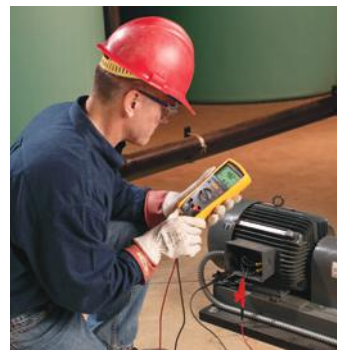
저저항 측정 및 접지 결함 연속성 테스트로 연결 및 모터 권선을 체크하십시오.
