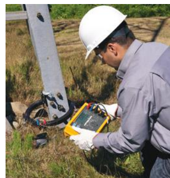
송전탑의 접지 루프 측정을 위한 변압기 액세스리 클램프
