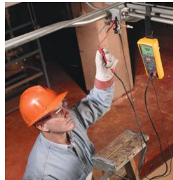
자석 미터 결이가 측정을 안전하게 하는 데 집중할 수 있도록 양손을 자유롭게 해줍니다.
