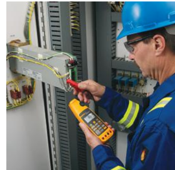
루프 단선 없이 프로세스 및 다른 오토메이션의 4~20 mA 신호 측정을 합니다.
